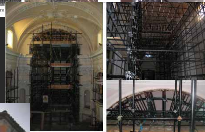
...ra con elementi giunto-tubo a maglia ...rtinatura della volta con elementi lignei
