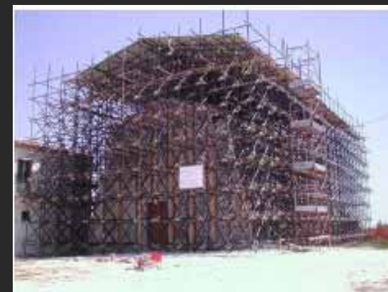
...ra con elementi giunto-tubo a maglia ...rtinatura della volta con elementi lignei
