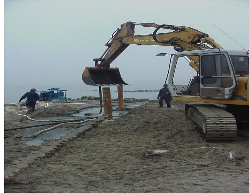
**FASE 1: INIEZIONE DI ACQUA FINO A -5 m CON COMPRESSORE**
